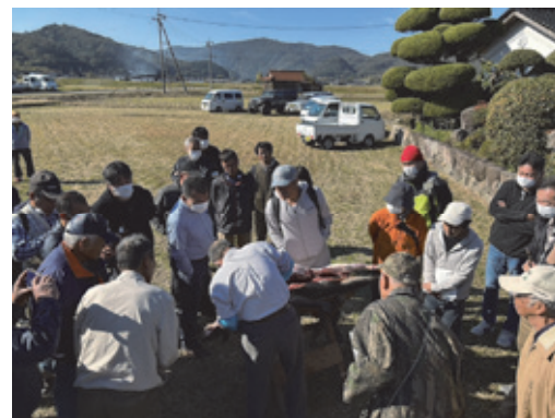
解体作業の実演
